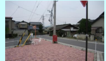
【道路事業】 歩道の設置及び空地の有効活用
