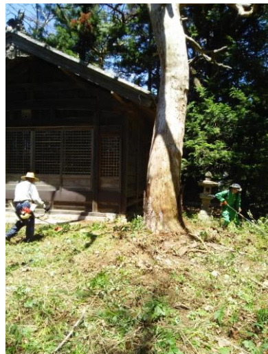
松が倒れれば、社殿が崩壊する。
