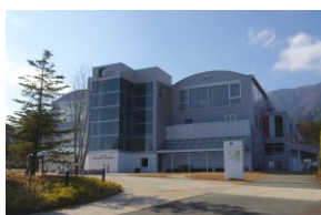
立体的な壁面構成と大きなガラス面によって圧迫感を軽減している例
