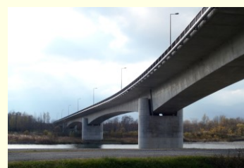
アーチによって圧迫感を軽減した橋げた
