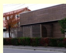
室外機に囲いを設置
