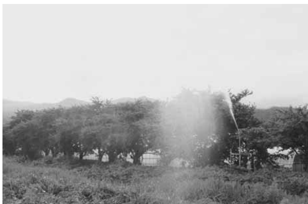
散水対策（スプリンクラー）
