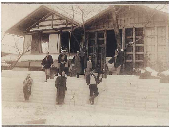
氷を切り出して積み込んで冷蔵庫とし、蚕種を保存した。
