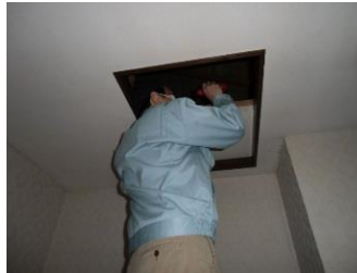
小屋組・梁の調査
