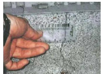
基礎ひび割れの調査
