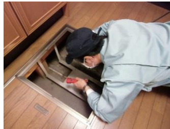
土台・床組・基礎の調査
