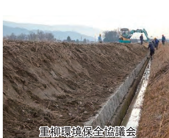
水路の嵩上げ（長寿命化活動）
