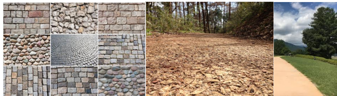
□環境に配慮した舗装の例 (左から自然石、木チップ、土系舗装)
