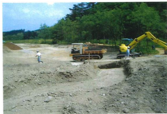
参考:上流側の造成当時の状況
