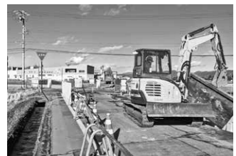
信号機設置に伴う三郷小南交差点改良工事
