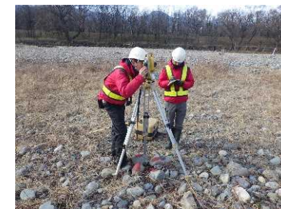
現地測量の作業イメージ
