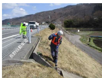
長野道上での測量(R5)
