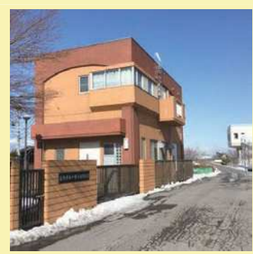
頭首工管理棟
