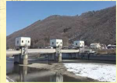
拾ヶ堰頭首工
