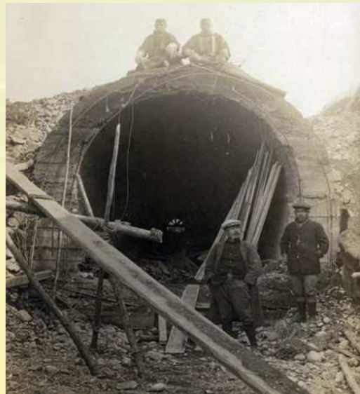
大正9年に、先人達の高い技術力により、馬蹄形現場打ちコンクリート管(口径φ3.3m)による梓川伏越し工事で旧サイフォンが完成しました。
