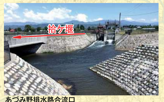
あづみ野排水路合流口 大雨・洪水時に、拾ヶ堰の中堀調整堰から万水川(よるずいがわ)へ排水が行われます。
