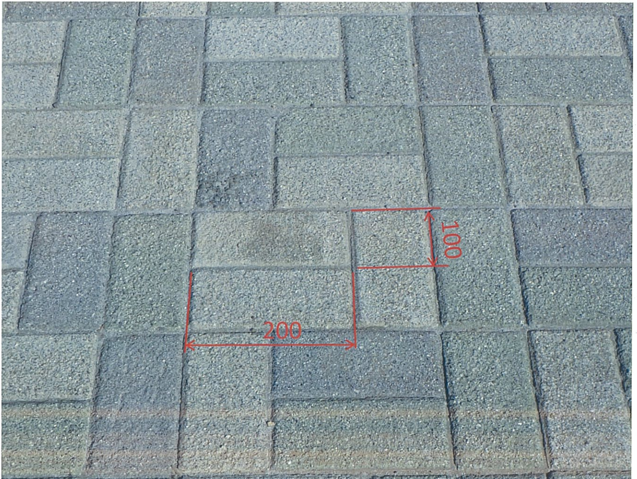
○インターロッキングブロックの状況
