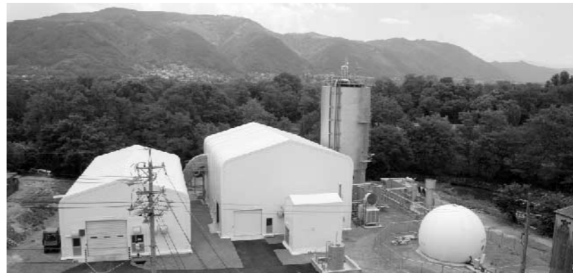
穂高クリーンセンターに隣接する乾式メタンガス発酵・固形燃料化施設
