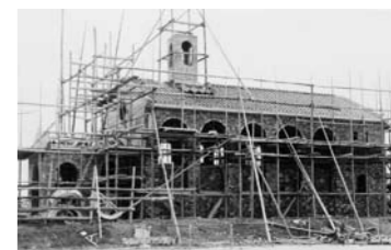
建設中の美術館本館
