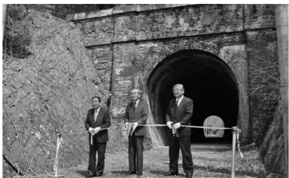
赤レンガに覆われたトンネルの前でテープカット
