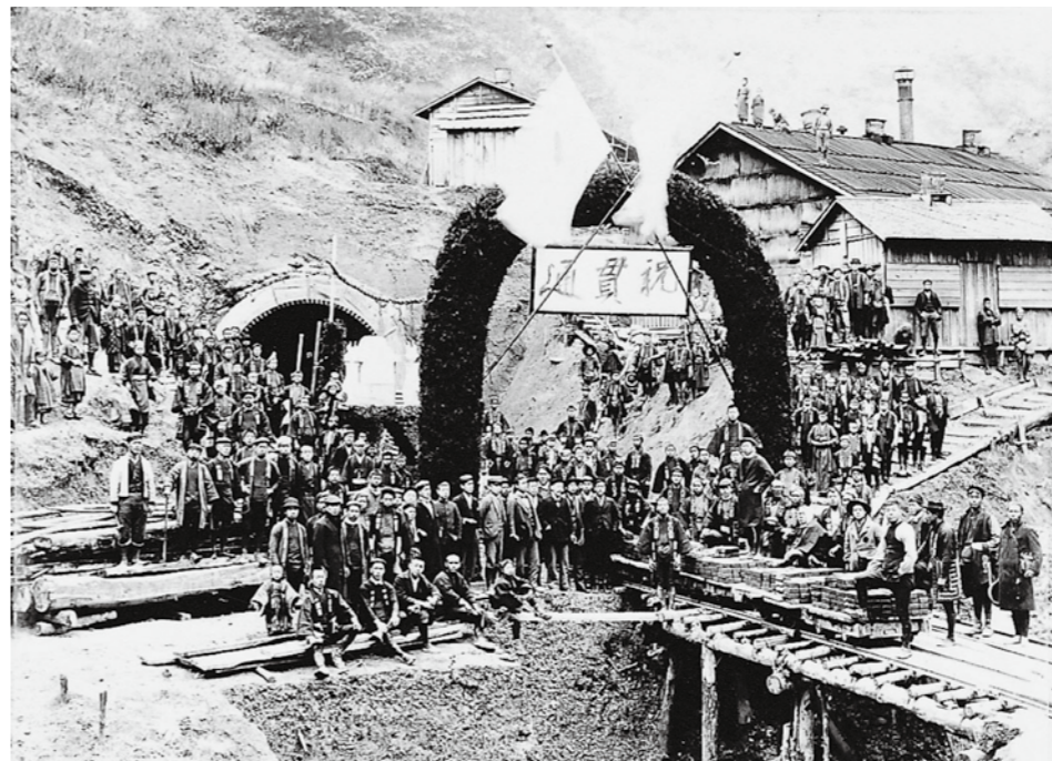
白坂隧道(トンネル)貫通記念 明治33年10月、明科東川手の池桜口でのトンネル貫通祝いのようす
