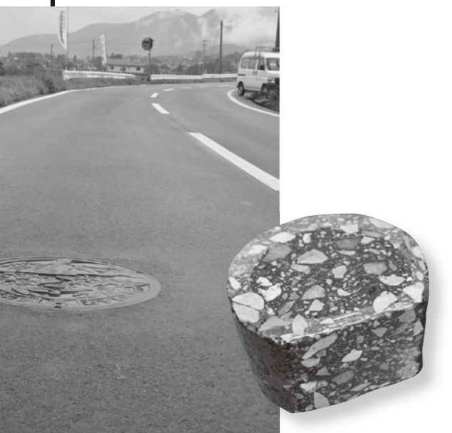
△細かく砕かれたガラスが入っているアスファルト合材で舗装した道路。
