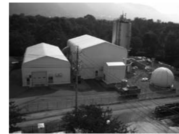
写真は乾式メタン発酵施設(実験施設)
