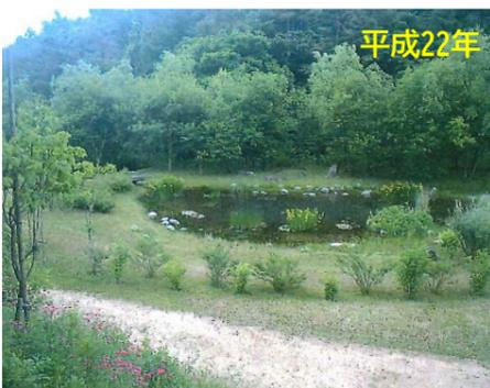
現在は一面草地に見えるが、下層には管理車が入れるよう碎石の路盤を確保、表層には土系の舗装を用いて仕上げられている
