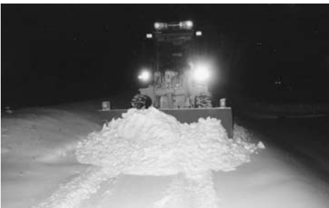
昨年度、100台の建設機械・トラクター等が除雪を延べ332時間、凍結防止剤の散布を延べ400時間行いました。また、除雪に関わる費用として約4,490万円を支出しました。
