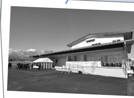
北部学校給食センターが完成
