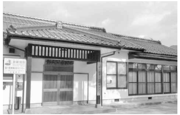
塗装工事が完了した公民館
