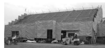
工事状況(講堂)
