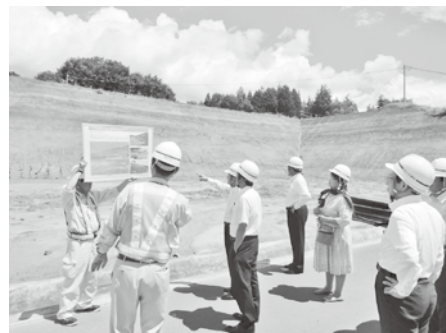
中部縦貫自動車道建設現場視察（高山市）
