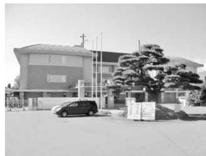
改修が始まった掘金支所
