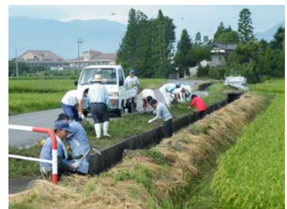
川普請の作業の様子
