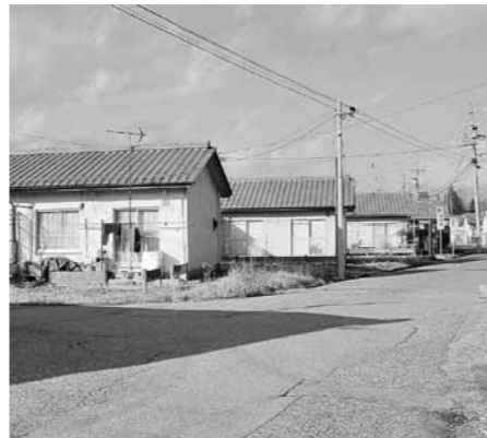
老朽化のため募集停止中の市営団地
