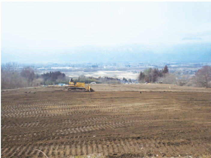
▲平成 27 年 2 月 整地作業の様子
