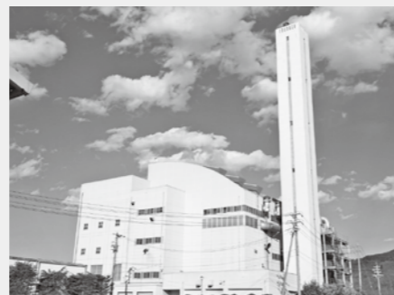
建て替えが予定されている穂高クリーンセンター
