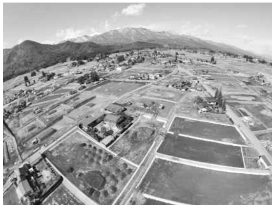
烏川地区の区画整理 (上空からの様子)
