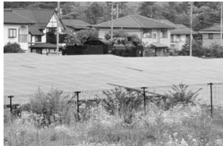
住宅団地付近に設置された大型太陽光発電設備
