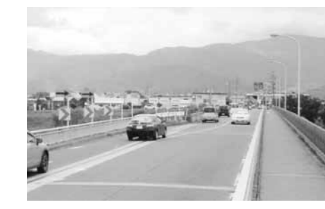
老朽化が著しく中央部が拡幅できないため、渋滞が激しい梓橋
