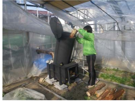
ビニールハウスを薪で暖めるハウスボイラー
