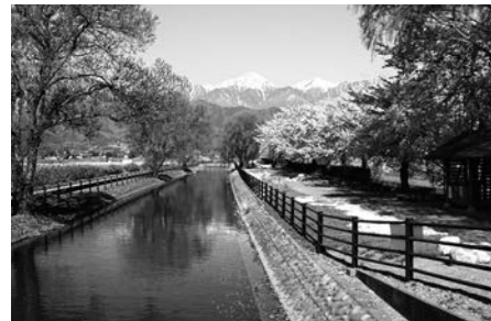
国道147号高家バイパス先線(本村)にある拾ヶ堰(平成橋周辺)
