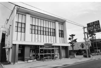
まちづくり会館 (豊科成相、国道 147 号線沿い)
