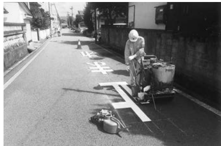
路面標示の復旧作業中
