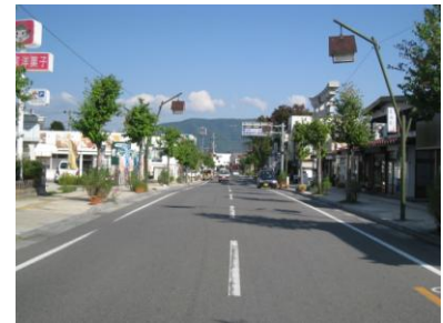
穂高駅前通りにおける電線裏配線化の例（穂高地域）
