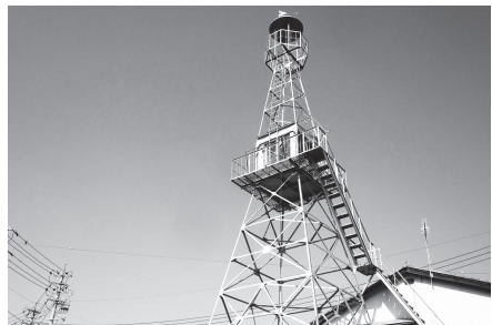
黒部ダム建設にかかわった火の見やぐら(穂高)
