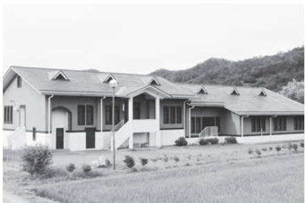
農業集落排水 川西浄化センター
