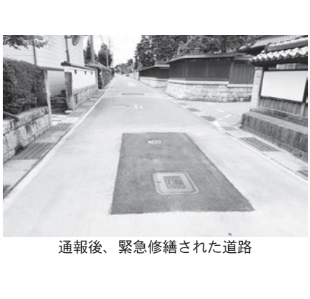
通報後、緊急修繕された道路
