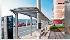
通路の屋根 (シェルター)
