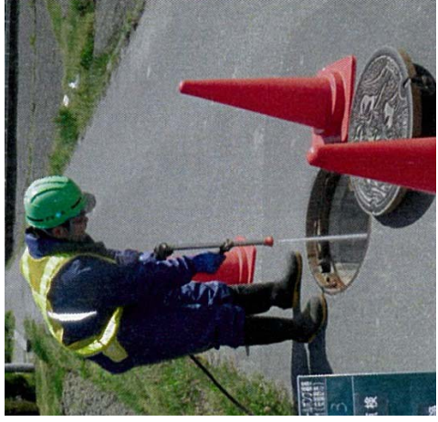
点検作業・清掃作業 左：道路上での作業 中：マンホールの清掃 右：マンホールポンプ制御盤点検
