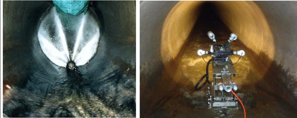
下水管内のカメラ調査、管内清掃、腐食マンホール蓋の交換及び補修
