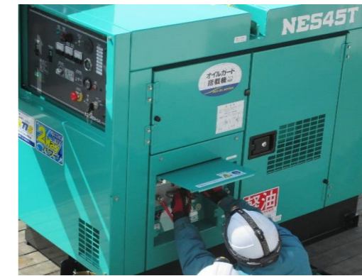
右:発電機から処理施設への電源接続 中:停電訓練時の発電機 左:購入した発電機(45kVA・15kVA)
