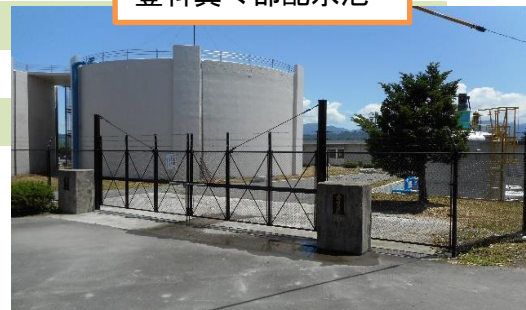
豊科真々部配水池
