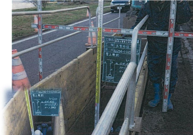
管布設状況(開削工法)
