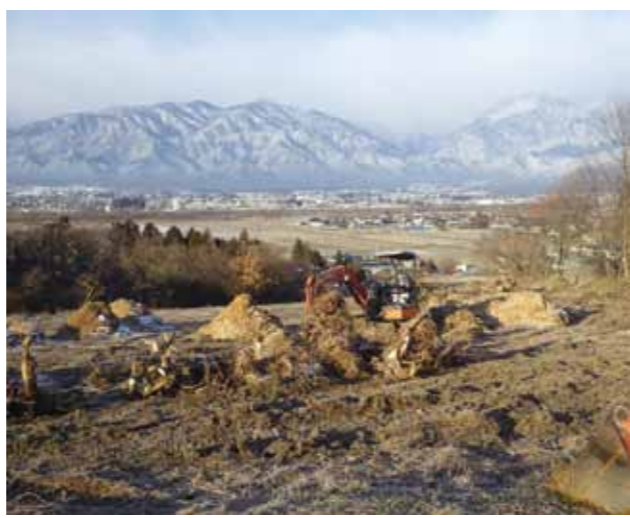
伐採した樹木の片づけの様子
