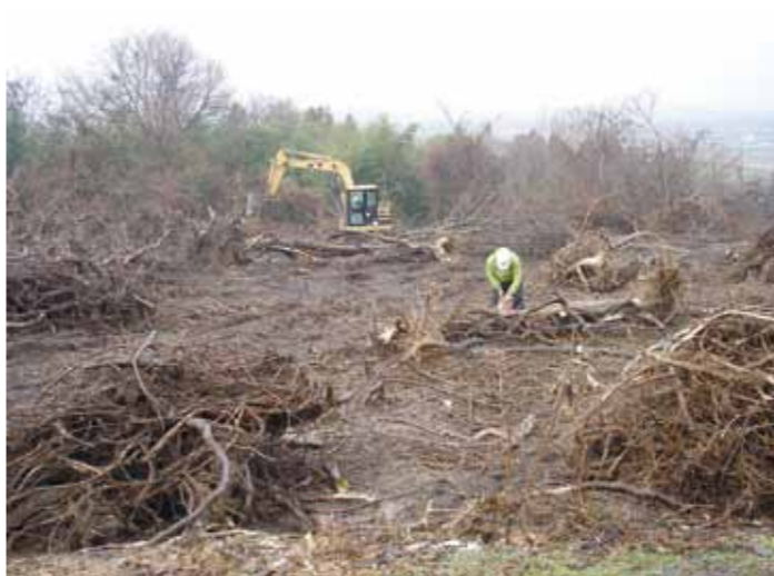
切り倒した木の抜根作業の様子
