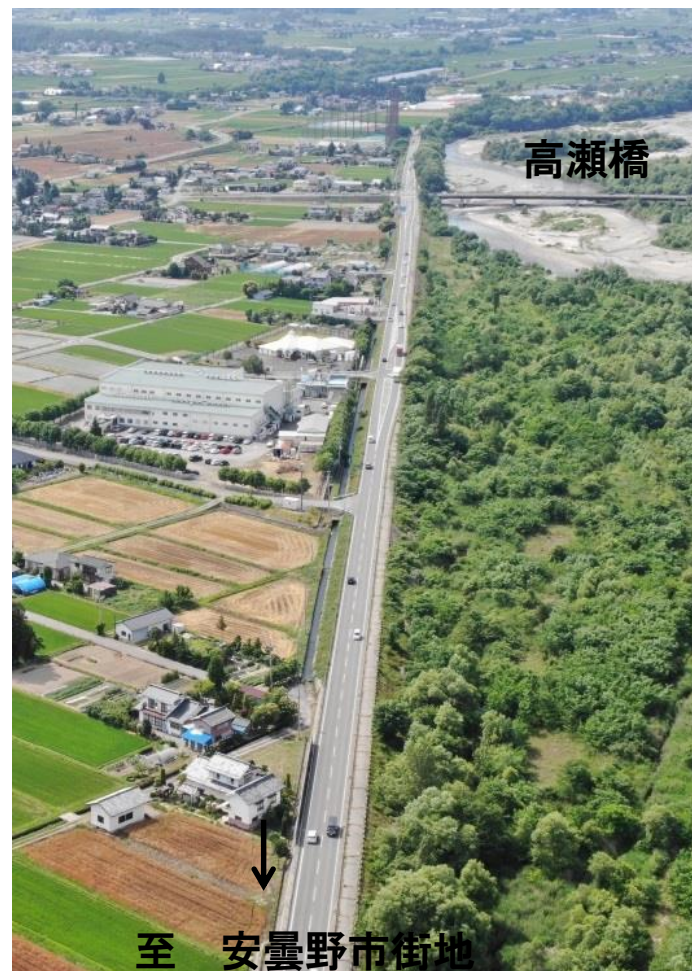
高瀬川右岸道路
