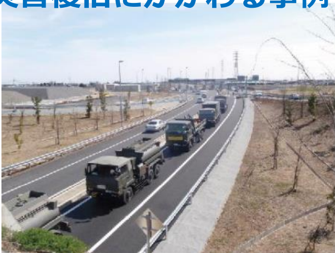
緊急車両走行のために開放された太田桐生IC付近（東日本大震災時）
