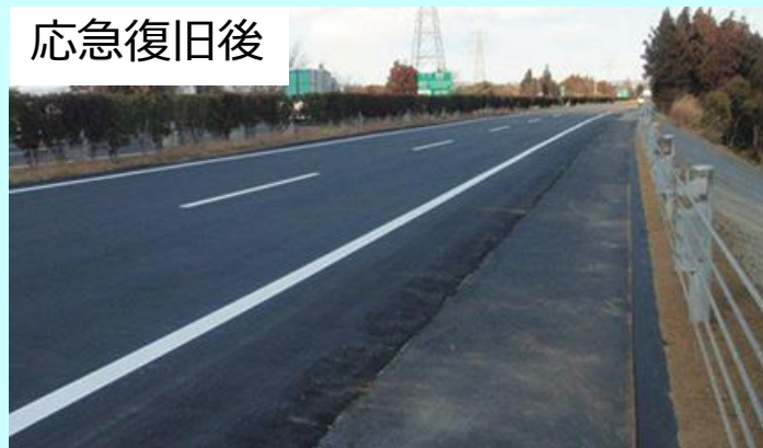
応急復旧後の様子（2011.03.17）
