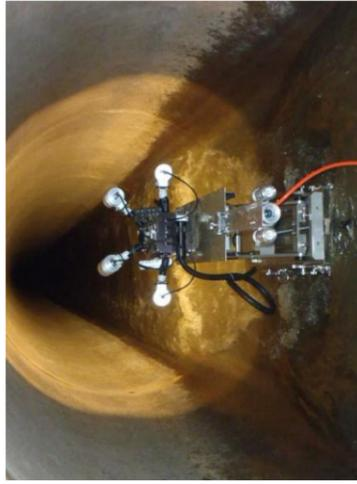
下水管内のカメラ調査、管内清掃、腐食マンホール蓋の交換及び補修
