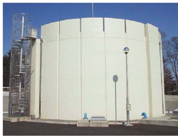
穂高地域 宮城水源地・配水池
