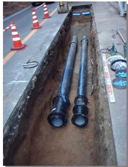
NS 形ダクタイル 鋳鉄管施工状況
