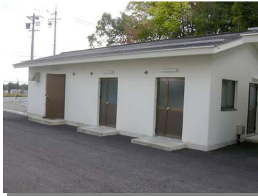
穂高地域 宮城水源地 ポンプ室・滅菌機室
