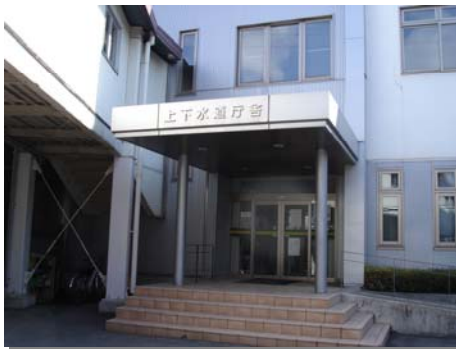
安曇野市上下水道庁舎
