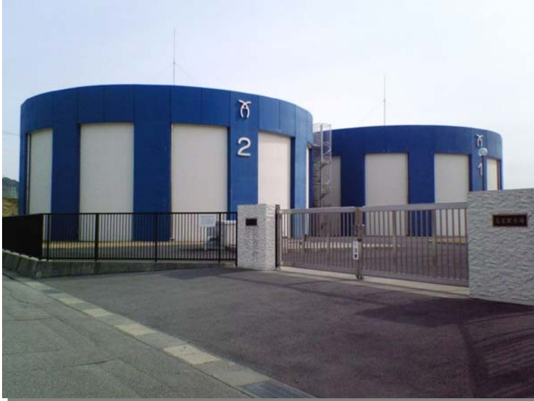
豊科地域 高家配水池 (重要拠点配水池)
