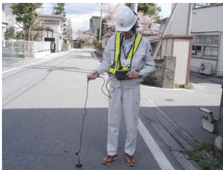
漏水調査作業
