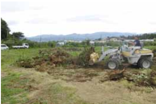
ホイルローダーによる集積作業
