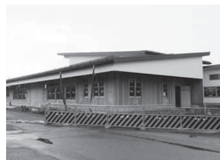
工事が再開された明科南認定こども園 (令和元年 12月27日撮影)
