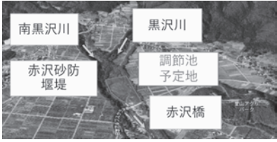
黒沢川調節池の工事始まる
