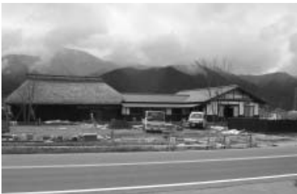
建設工事も最終段階・三郷やすらぎ空間施設
