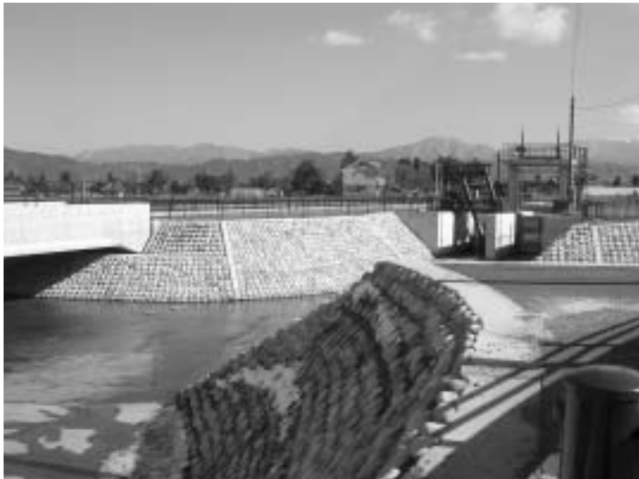
捨ヶ堰排水口中堀ゲート
