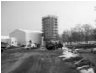
建設中のバイオマスエネルギー実験事業実証施設
