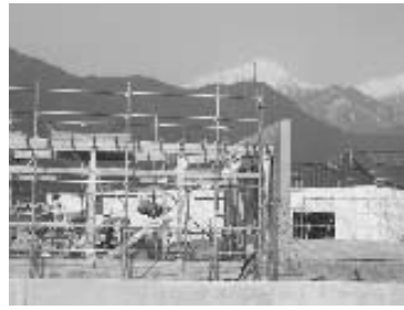
堀金保育園建設現場
