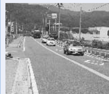
塗り替えられたセンターライン
