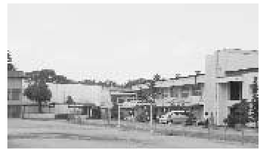
穂高北小耐震化工事
