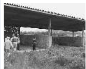
水分調整施設の一つは、ほとんど利用がない状態
